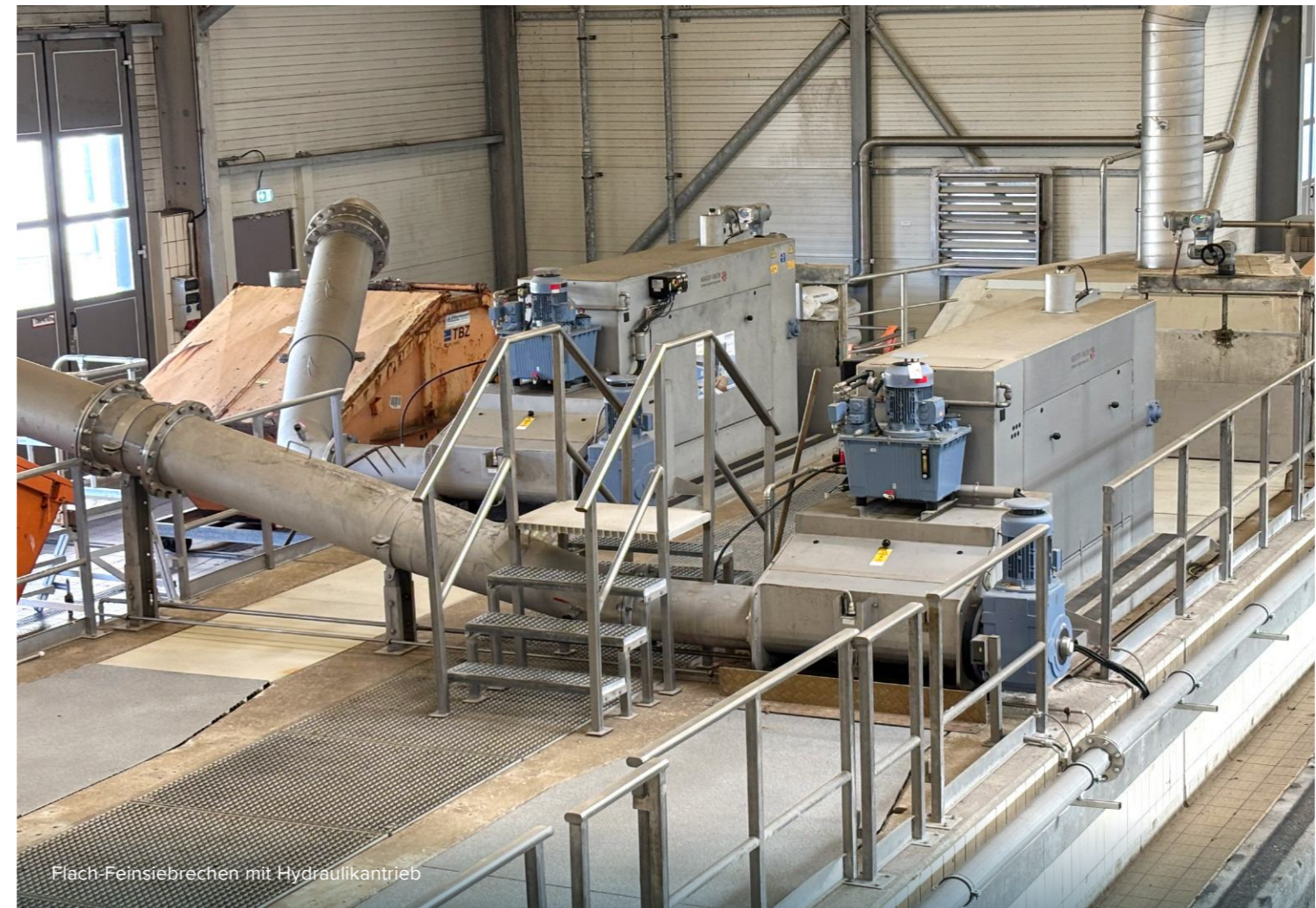
Flach-Feinsiebmaschinen mit Hydraulikantrieb
