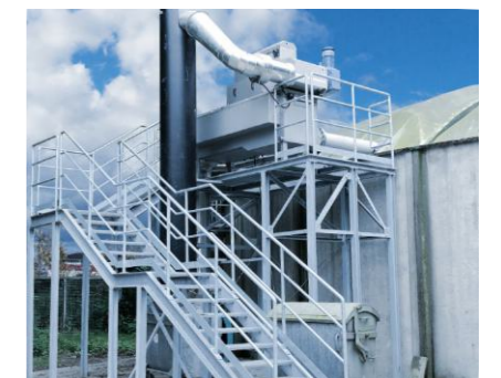
Stahlbaukonstruktionen und Podeste
